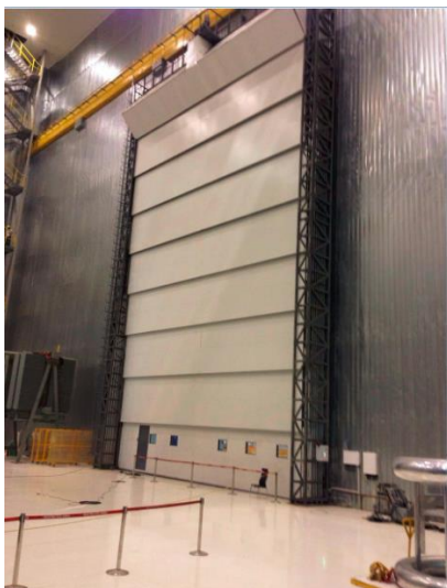
Shielding Rolling Door 2
